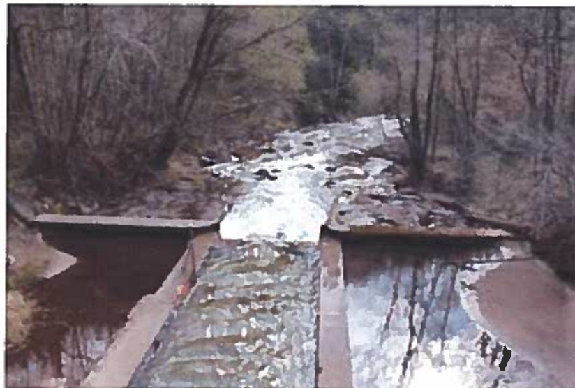
Abbildung 2: Messgerinne Staatsgrenze (Blickrichtung flussab) 2019
