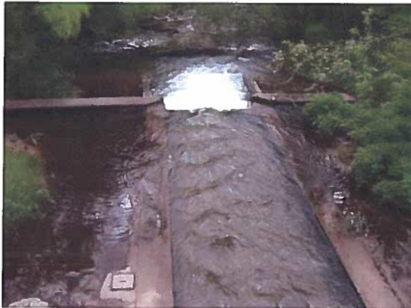
Abbildung 1: Messgerinne Staatsgrenze (Blickrichtung flussab) 2014
